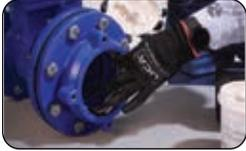
4 Lubricar el empaque interior del adaptador
