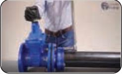
6 Una vez presentado el adaptador, inicar el apriete secuencial de los tornillos a un torque de 30 lbs/ft. Para fijar el anillo a la tubería de PEAD
