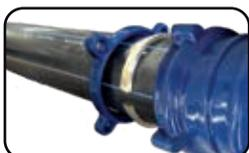
4 Insertar la tubería en el cople hasta medida B como máximo. La separación entre espigas (Dimensión "Y") no mayor al 12% de la longitud total del cople A para asegurar una buena instalación ( ver paso 1)
