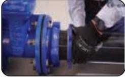
5 Insertar la tubería en el adaptador hasta llegar al tope de la brida.
