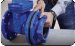
1 Alinear empaque de neopreno y la brida del adaptador a la conexión bridada o válvula, colocar tornillos, tuercas y realizar apriete secuencial para hacer el sello
